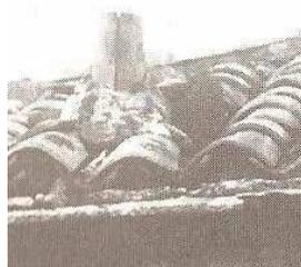
Photo 26 : Conduit d'évacuation de la fumée en tuiles (48)
