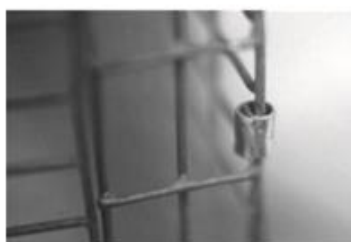
Clips en zinc mis en place
