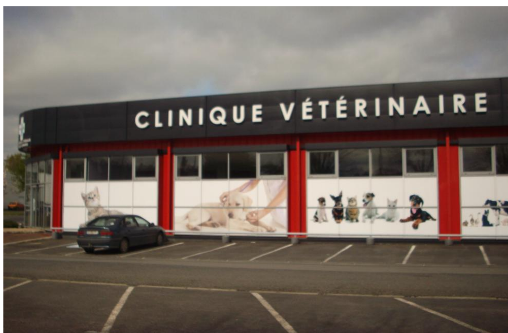
Figure 44 : Façade d'une clinique vétérinaire du réseau Mon vétéo suite au changement d'identité visuelle
