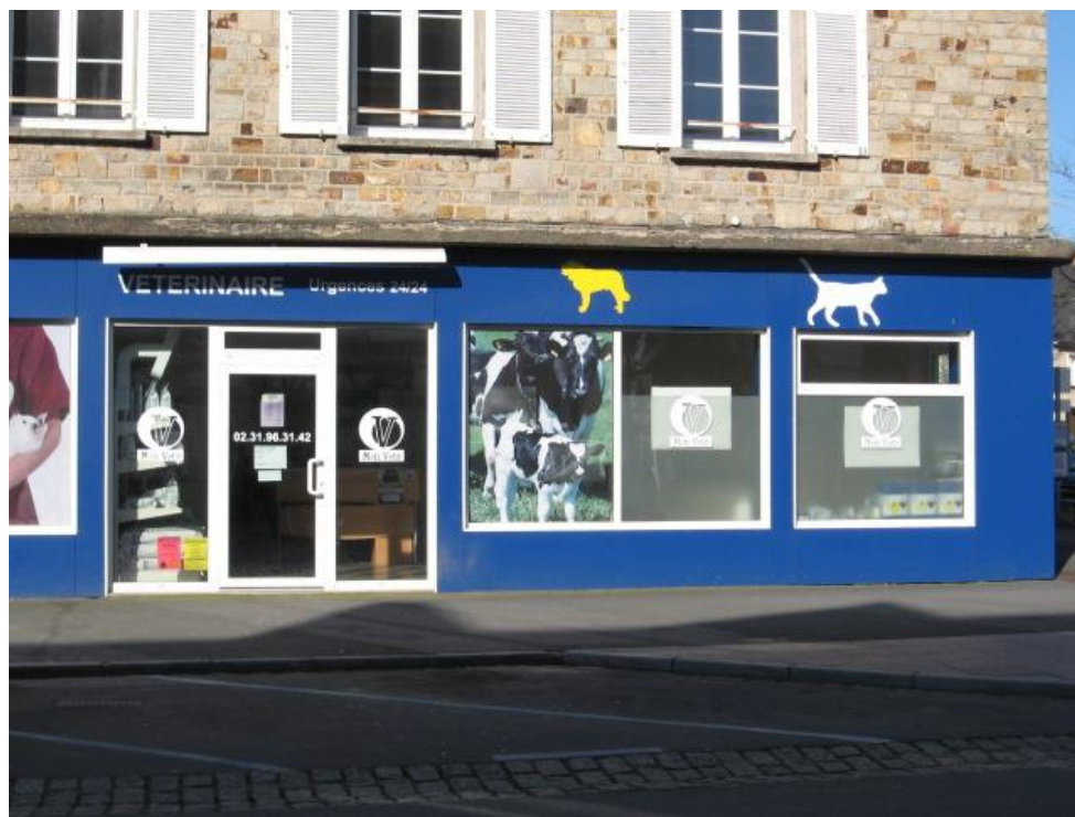
Figure 43 : Façade d'une clinique vétérinaire du réseau Mon vétéo
