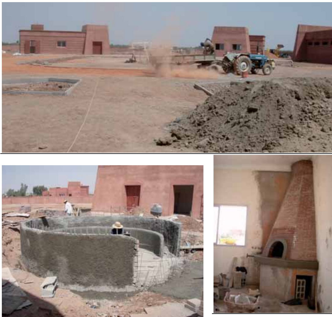
Photos 14 à 17 : Le nouveau Haras de Marrakech en construction, juin 2008
