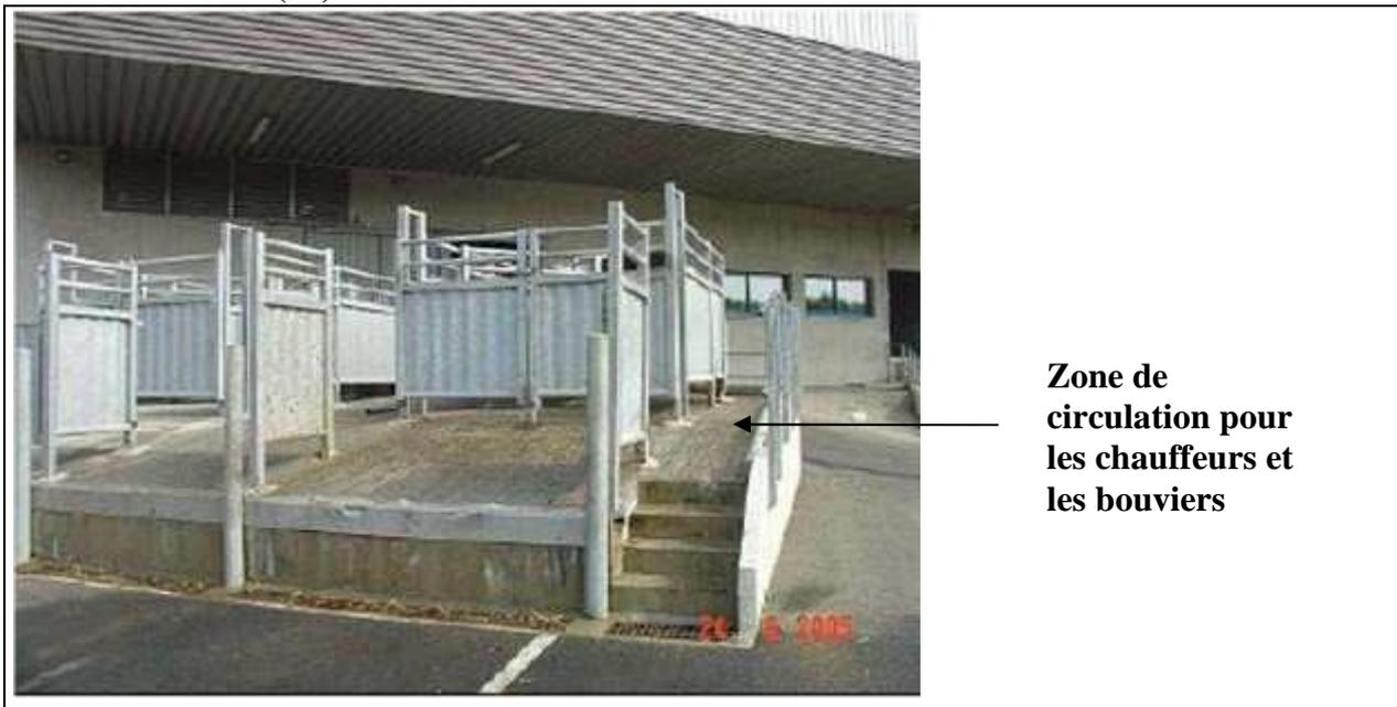
Les quais de déchargement (Figure 5) devraient être constitués de structures limitant les contacts entre les bovins et les manipulateurs. Les parois pleines permettent de limiter les risques de blessures et la clôture de la zone de déchargement prévient l'échappée d'un bovin. La présence d'un sol rainuré limite les glissades des bovins, d'après **LEMOINE *et al.* (71)**
